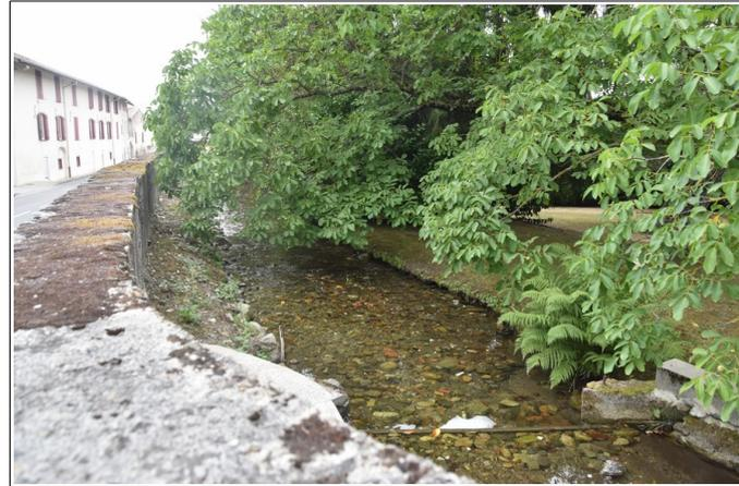
Figure 2: bief du Touyre en bordure de la rue Denis Papin ; on notera la faible hauteur de sa rive droite.
